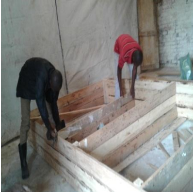
Photos 2 Mesurage des dimensions des cages
