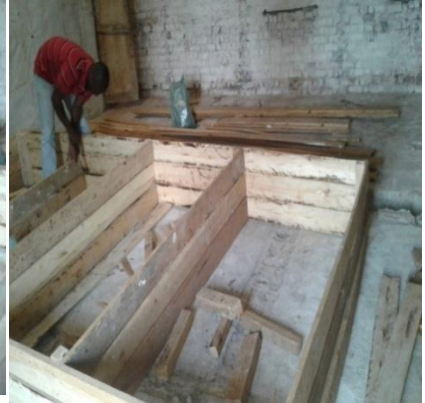
Photos 3 Assemblage des planchettes
